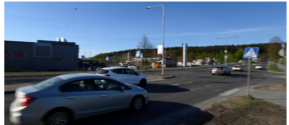
Kuva 15, Kahden ajokaistan ylittävä valo-ohjaamaton suojatie Possijärvenkadun liittymässä.
